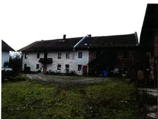
Abbildung 6: Bestehendes Wohngebäude (Nr.1)
