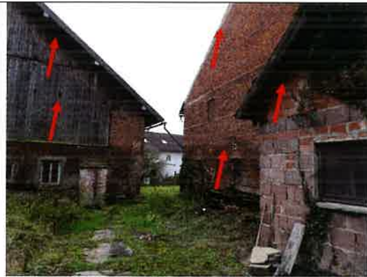
Abbildung 13: Potenzielle Quartiere an Gebäuden
